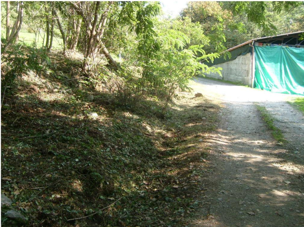
Foto n.6 Lungo alcuni tratti la cunetta è parzialmente riempita di terra e non assolve completamente al drenaggio delle acque meteoriche superficiali
