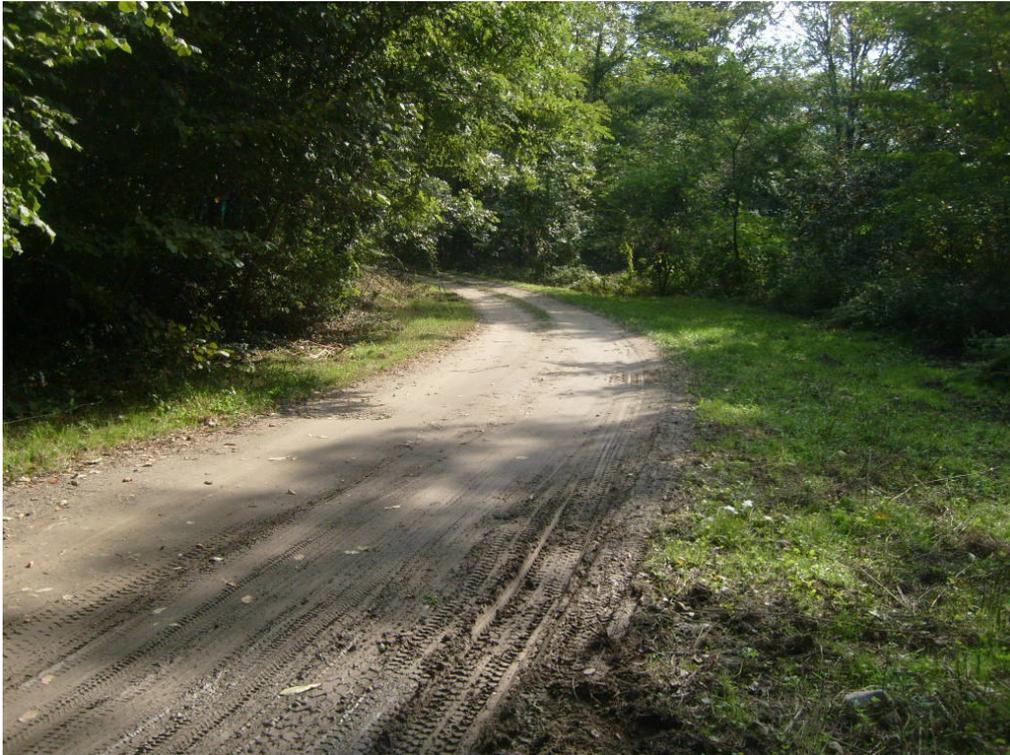
Foto n.3 Verso monte, la strada è in terra battuta formata in parte da terreno non granulare che durante le piogge si trasforma in fango; inoltre il piano strada non ha una pendenza definita
