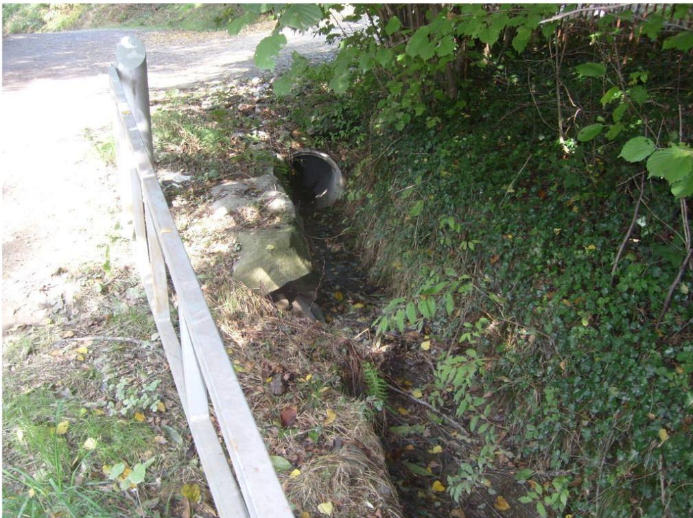
Foto n.2 A monte dell'incrocio l'imbocco del tubo che lo attraversa in sotterraneo. La cunetta è sagomata nel terreno
