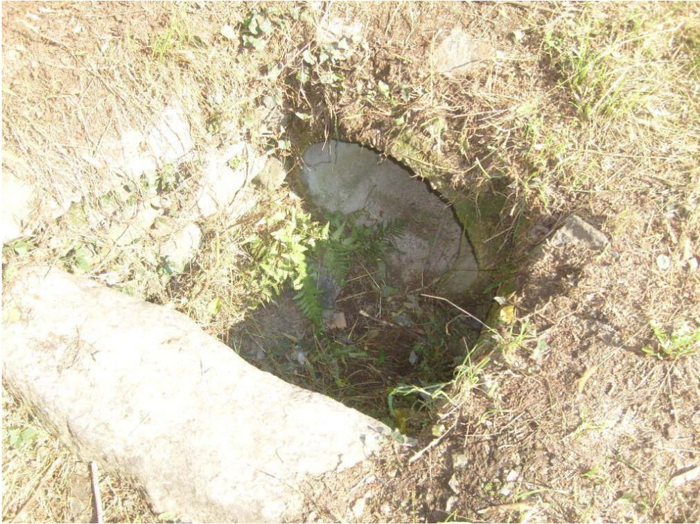
Foto n.7 Attualmente non ci sono pozzetti ma dei rompi tratta aperti così da poter eseguire la manutenzione e togliere i detriti che si depositano all'interno dei tratti intubati
