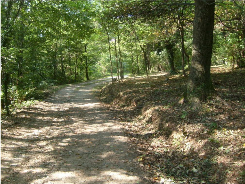
Foto n.5 La cunetta è percorsa solamente dalle acque raccolte nella parte più a monte, nel tratto centrale della strada, le acque superficiali si accumulano e scorrono verso valle lungo il piano strada dove sono evidenti i solchi di erosione
