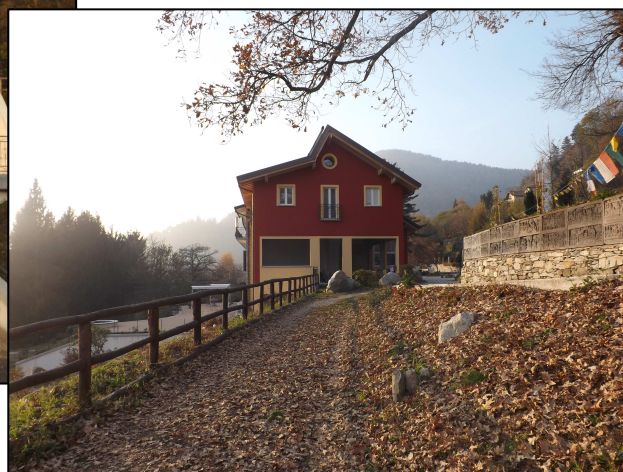
Il fabbricato “Sede del Centro”- Il fronte est.
