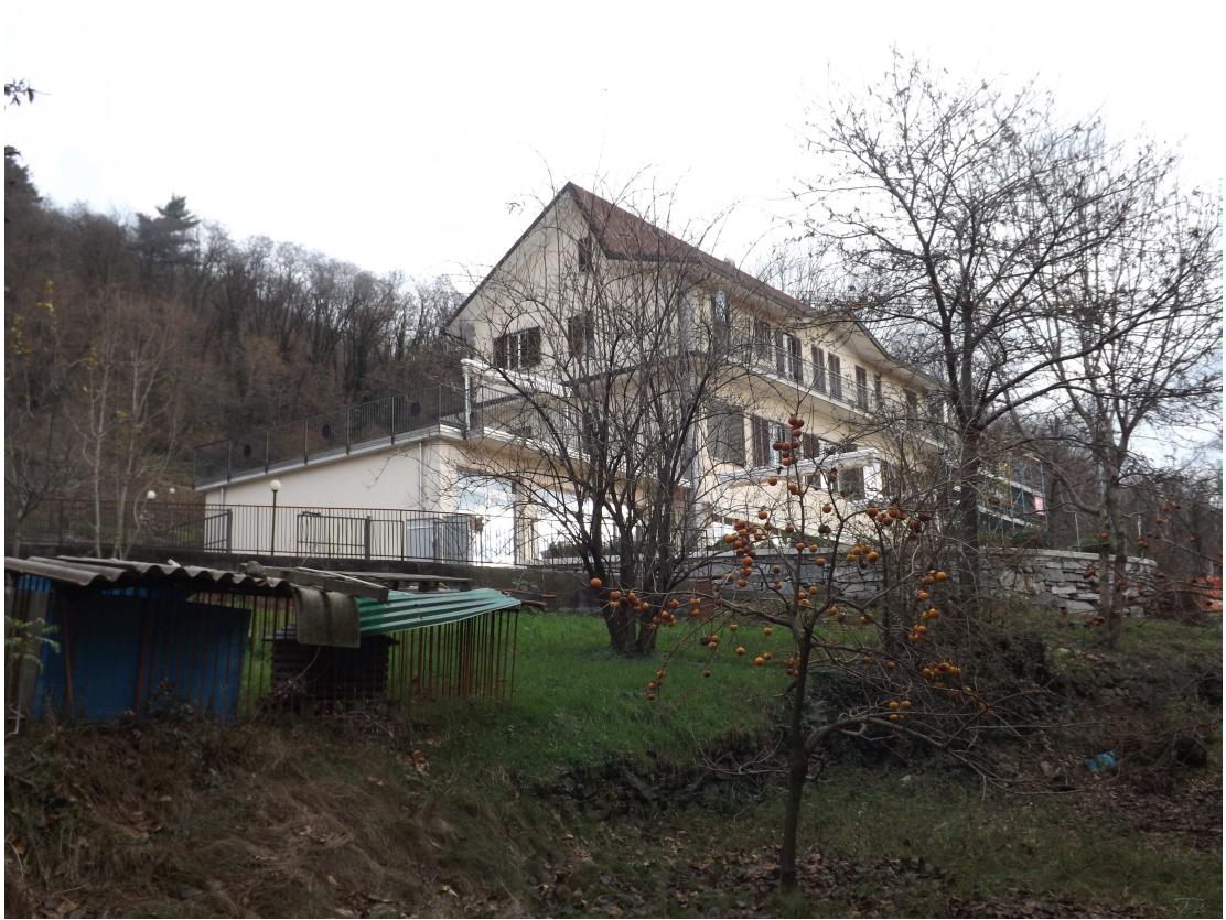
FOTO n. 7- Fabbricato sede del Centro. Vista Sud Ovest (dal vialetto pedonale).
