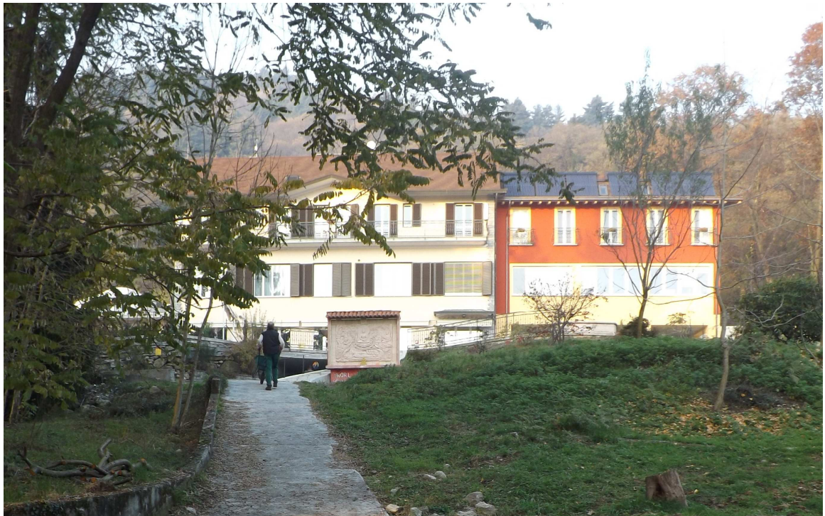
FOTO n. 9- Il fabbricato sede del Centro (fronte sud) visto dalla “Tettoia Grande”.
