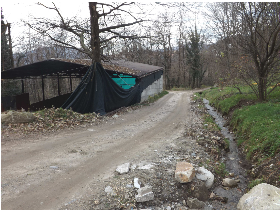
FOTO n. 10- Il fabbricato “Tettoia Grande” (fronte Est).
