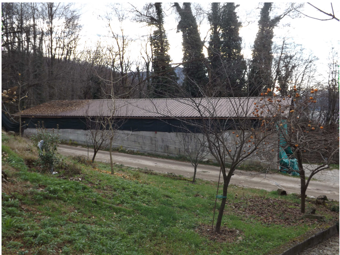
FOTO n. 8 - Il fabbricato “Tettoia Grande” (fronte nord) visto dal vialetto pedonale
