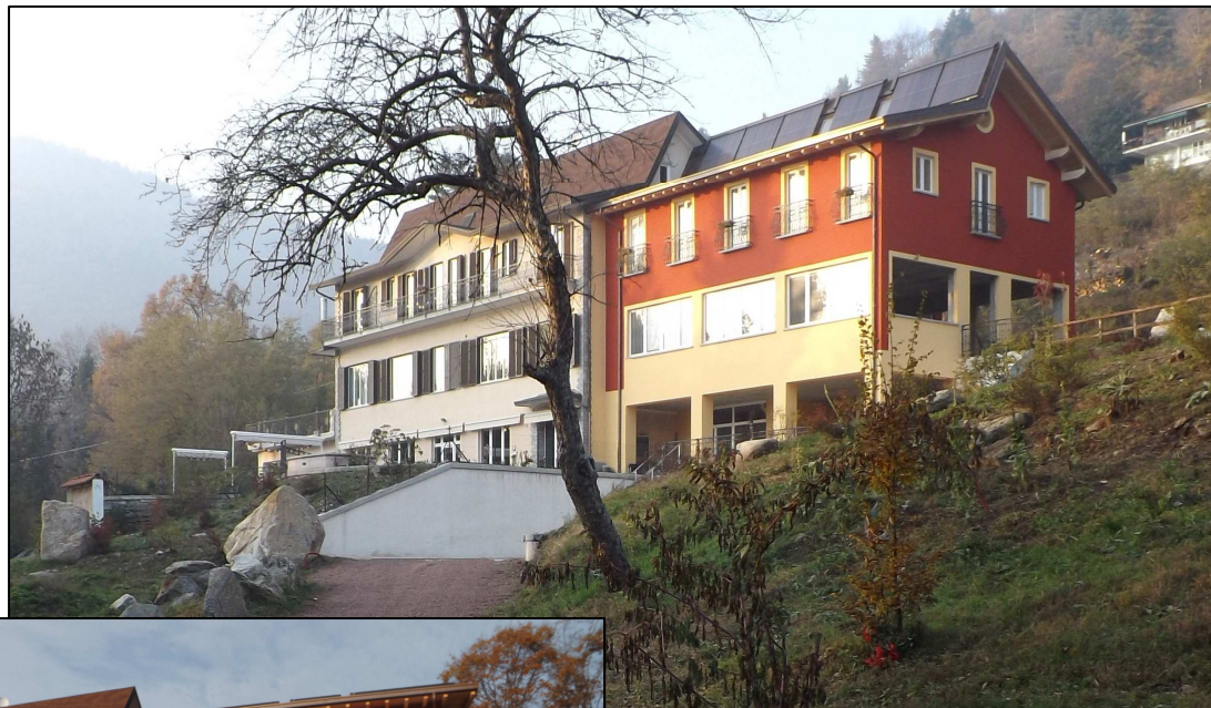
FOTO n. 15- Il fabbricato “Sede del Centro”- Il fronte sud-est.
