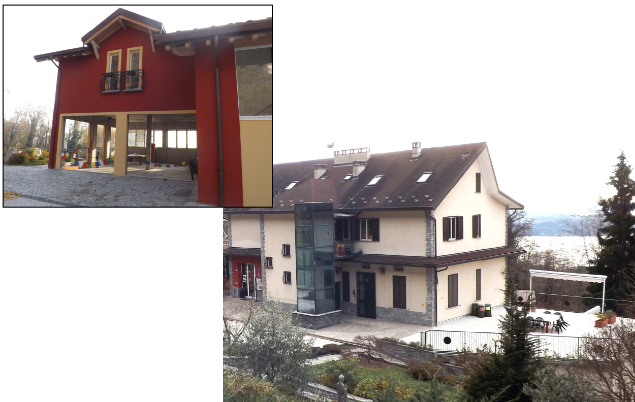
FOTO n. 17- Il fabbricato “Sede del Centro”- Il fronte nord -ovest.
