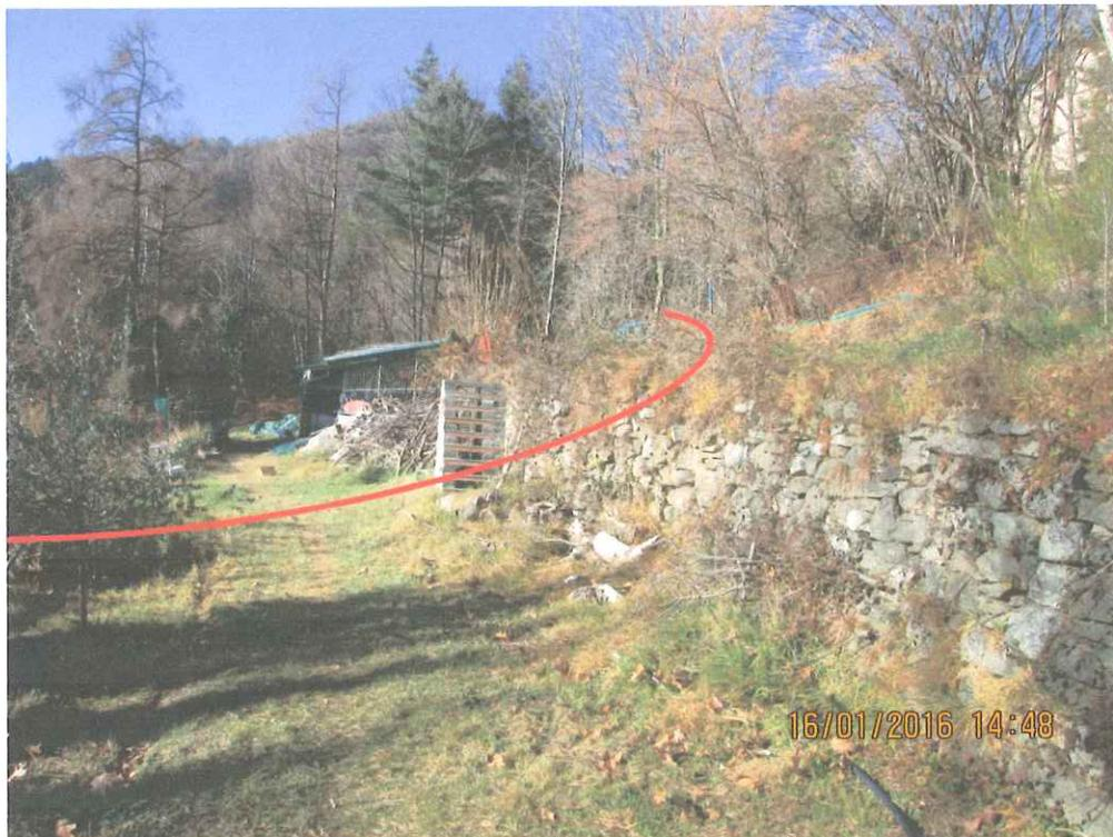
Foto n.9 La strada giungerà alla base del terrazzo inferiore, anch'esso circa orizzontale e stabile. Il terreno avente caratteristiche geotecniche buone è presente alla profondità compresa tra 2,00 metri e 2,40 metri
