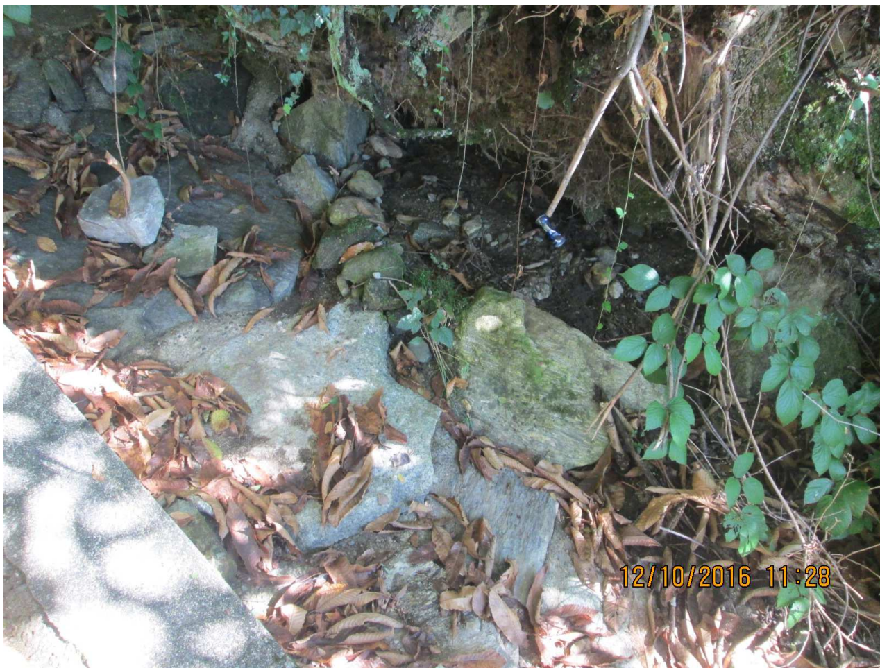
FOTO n. 13- Strada . Via Albagnano. Tratto con muretto d'argine. Particolare dell'alveo
