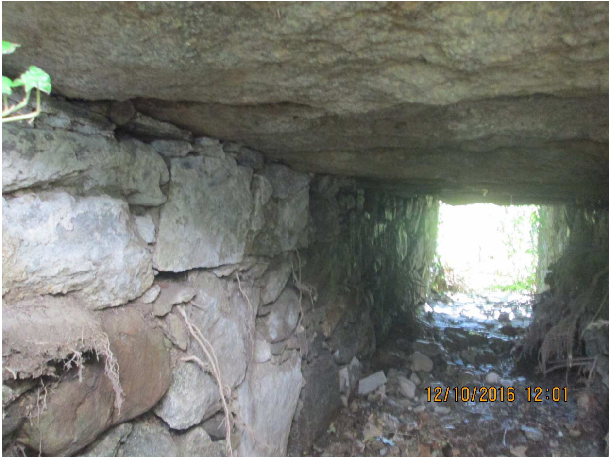
FOTO n. 17- Strada . Via Albagnano. Tratto di attraversamento in sottostrada.
