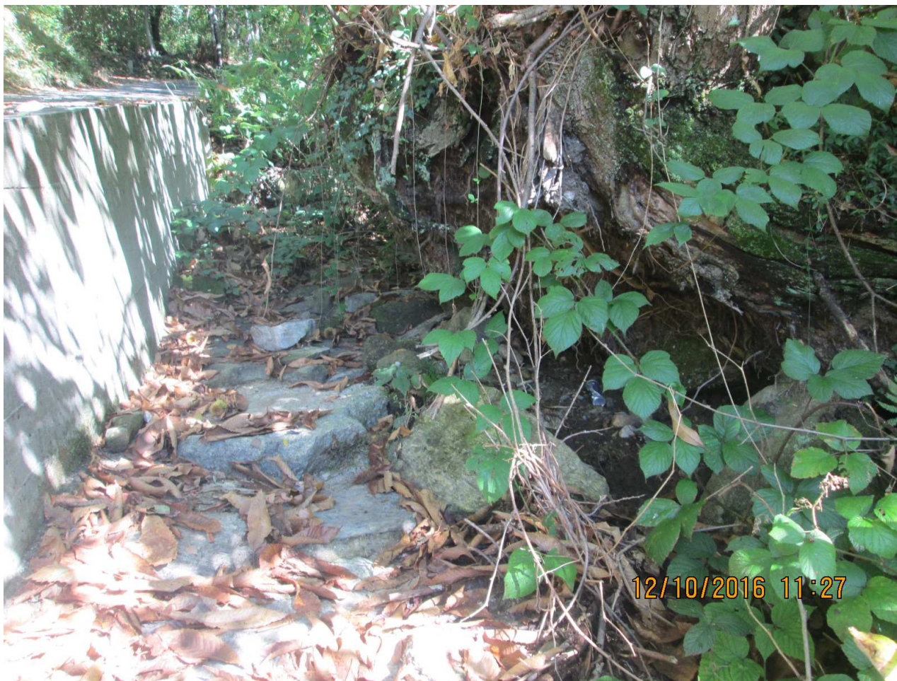
FOTO n. 14- Strada . Via Albagnano. Particolare del tratto con muretto d'argine. Vista a salire
