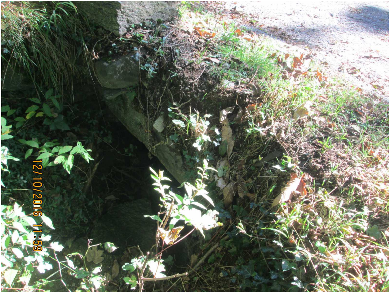
FOTO n. 16- Strada . Via Albagnano. Tratto di attraversamento in sottostrada in prossimità della curva.
