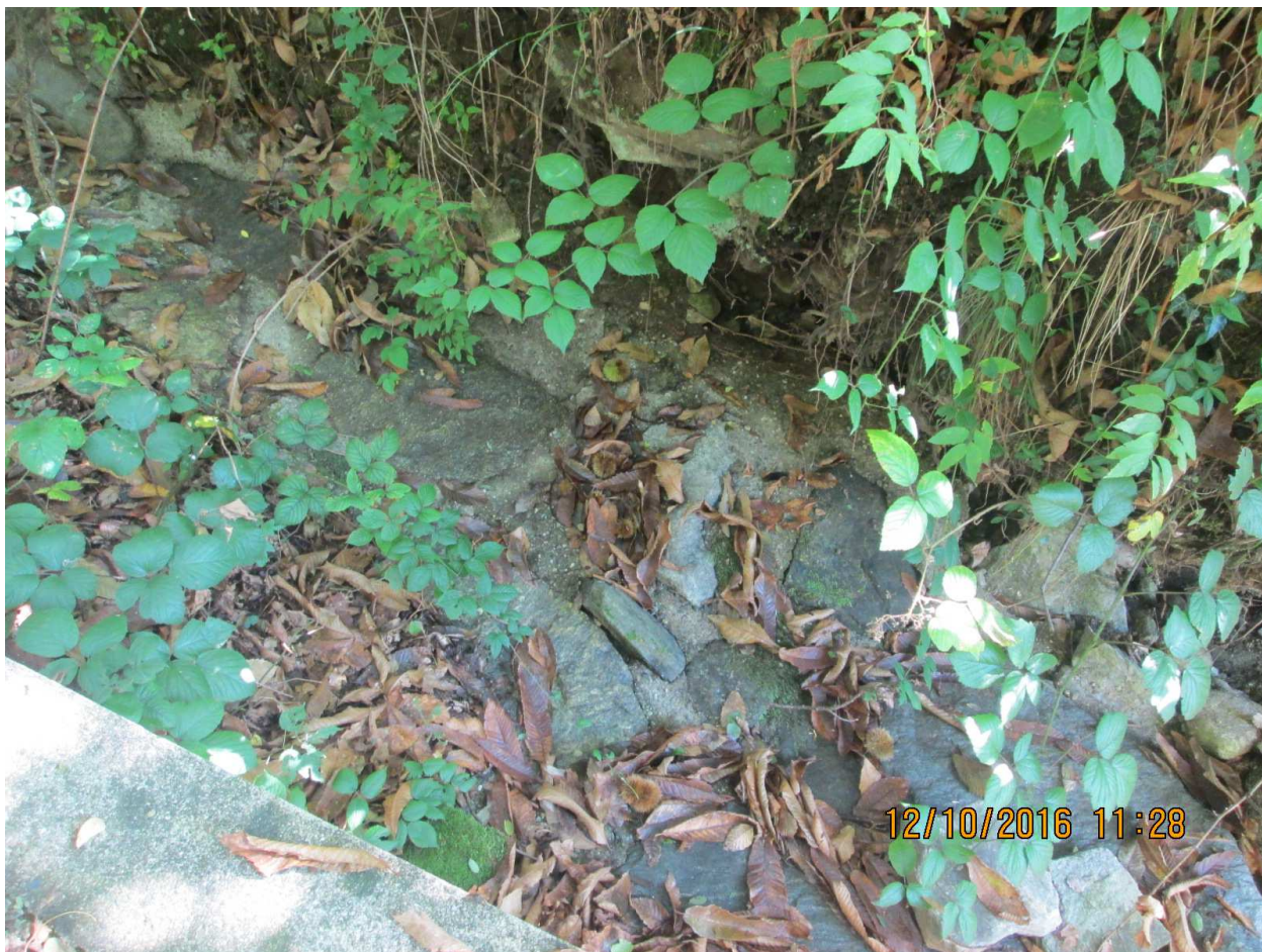
FOTO n. 15- Strada . Via Albagnano. Tratto con muretto d'argine. Particolare dell'alveo nel punto sotto l'albero.
