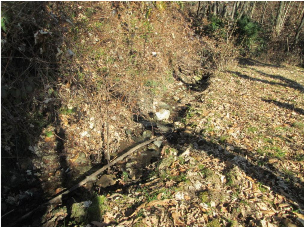
Foto n.2 Panoramica di un tratto del fosso in terra posto a lato della pista di accesso alle sorgenti. Il progetto prevede, lungo la sponda destra, la posa di croste di pietra cementate e lungo l'alveo l'asportazione di parte del terreno alluvionale che ne riduce la sezione
