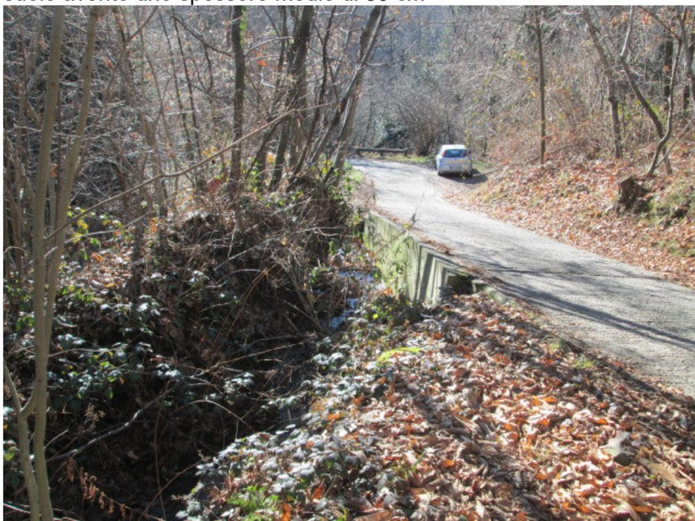
Foto n.6 All'imbocco della pista sterrata che porta alle sorgenti il fosso cambia direzione e si sviluppa parallelamente a Via Albagnano. L'alveo è inciso e lungo la sponda sinistra evidenzia alcuni tratti in erosione
