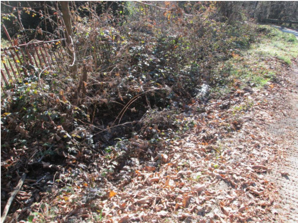
Foto n.10 In prossimità dell'attraversamento della strada carrozzabile l'alveo si allontana da Via Albagnano fino ad incrociarla in corrispondenza del tombino di attraversamento. L'alveo è separato dalla strada da un ampio setto in terra e non presenta erosione spondale significativa
