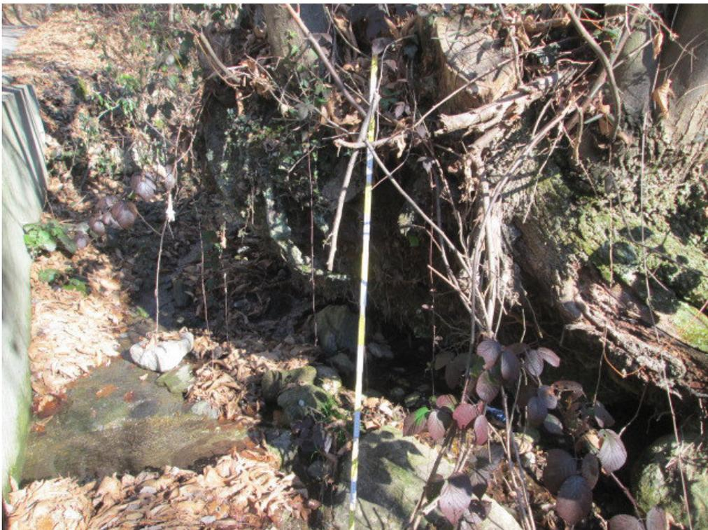
Foto n.8 Particolare del tratto in erosione, il setto in terra è completamente staccato dall'alveo e sostenuto dall'apparato radicale di un albero. Il crollo del setto in terra comporterebbe l'ostruzione della sezione di deflusso col conseguente pericolo, in fase di piena del rio, di esondazione della strada carrozzabile.
